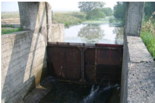
Рис. 2 – Шлюз-регулятор мелиоративной системы «Тинки-2» ОПХ Полково
