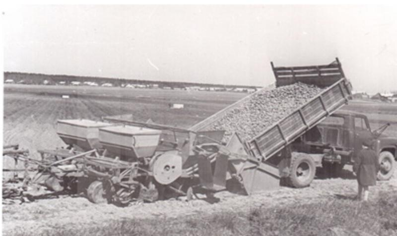
Рис. 1 – Загрузка сажалки КСМ-4А из универсальных самосвальных средств
