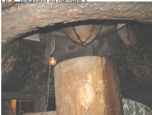
Рис. 3 – Установка кольцевого струйного аппарата на линии рециркуляции Новочеркасской ГРЭС перед лопатками осевого насоса
