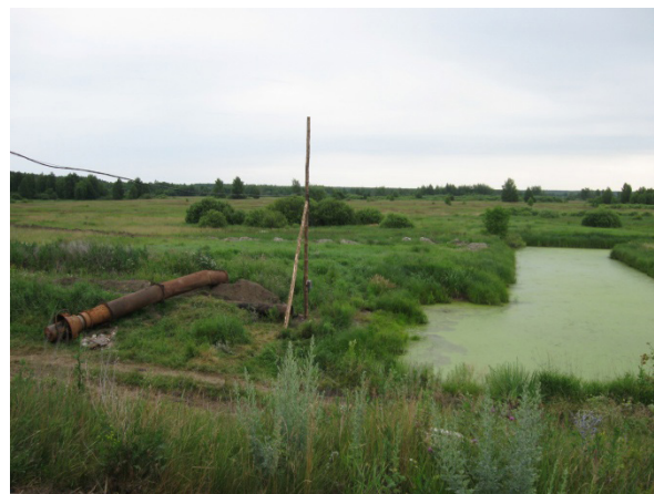
Демонтированная насосная станция на полевой системе «Макеевский Мыс»
