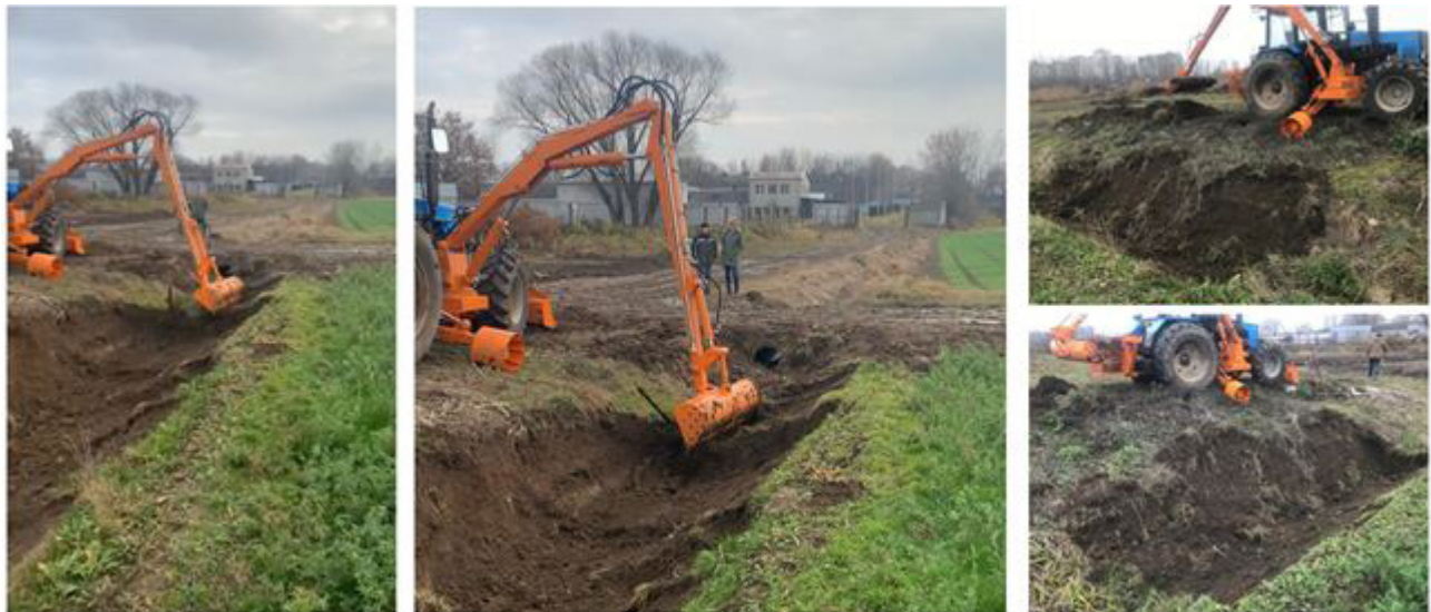
Рис. 2 – Работа каналоочистителя ОКН-0,5
