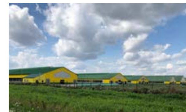
Рис. 1 – Внешний вид корпусов молочного комплекса Fig. 1 – The appearance of the buildings of the dairy complex
